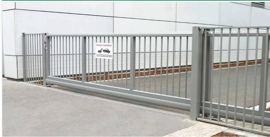
Sicher montiert vor Ort
